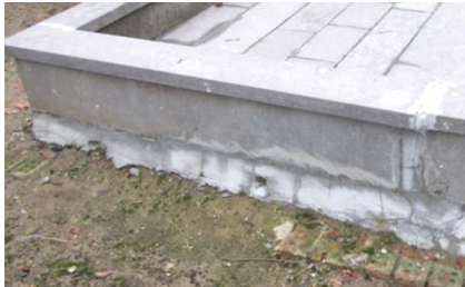
Proven, onbeholpen uitvoering van het voegen en plamuren
