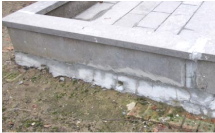
Proven, onbeholpen uitvoering van het voegen en plamuren
