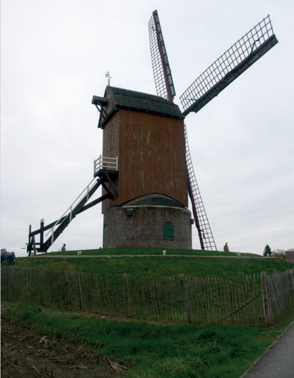
FIG. 1 De Wullepitmolen in Zarren. In 1944 beschermd als monument op basis van de wet van 7 augustus 1931 (© F. Becuwe, Keiem).
