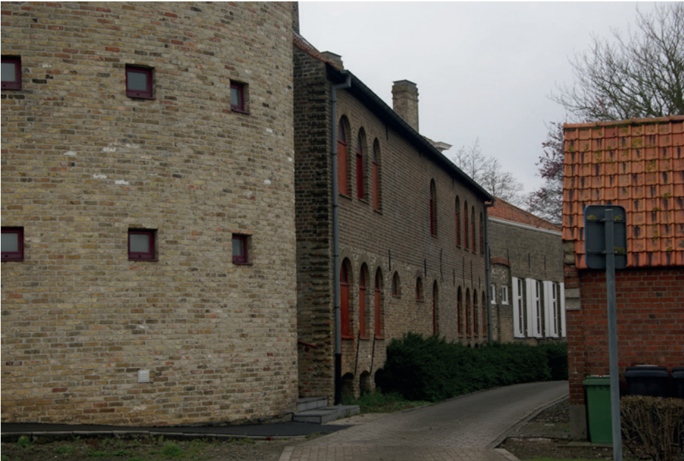
FIG. 22 Brouwerij-mouterij de Snoek in Alveringem. Horizontale bouwnaad als verwijzing naar de 19 de -eeuwse uitbreiding met een bovenverdieping (© Mout- & Brouwhuis de Snoek, Alveringem).
