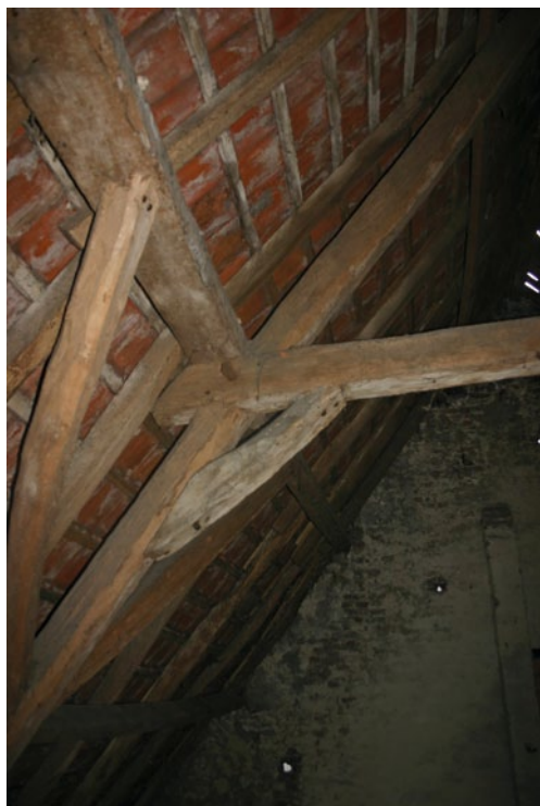
FIG. 54 Een niet geïsoleerd dak van een woning in Hansbeke gezien langs de binnenzijde (foto Halewijn Missiaen)
