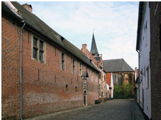
FIG. 6 Efflorescentie (zoutuitbloei) op de gevel van een huis in het Begijnhof van Diest na de overstroming in 1998 (foto Kris Vandevorst)
