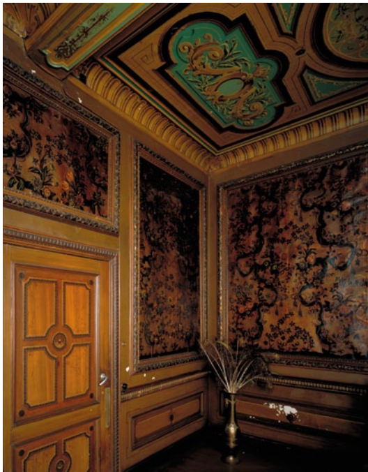
FIG. 25 Kostbare historische afwerkingsmaterialen zoals goudleder (hier in de St. Bernardusabdij in Bornem) zijn zeer gevoelig voor veranderingen van relatieve vochtigheid (copyright beeldbank Onroerend Erfgoed)
