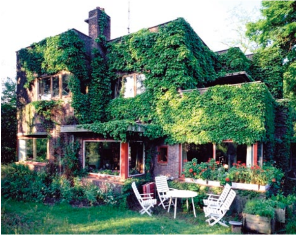
FIG. 104 Klimop tegen de gevel van historische villa Roze Konijn in Sint-Denijs-Westrem (copyright beeldbank Onroerend Erfgoed)
