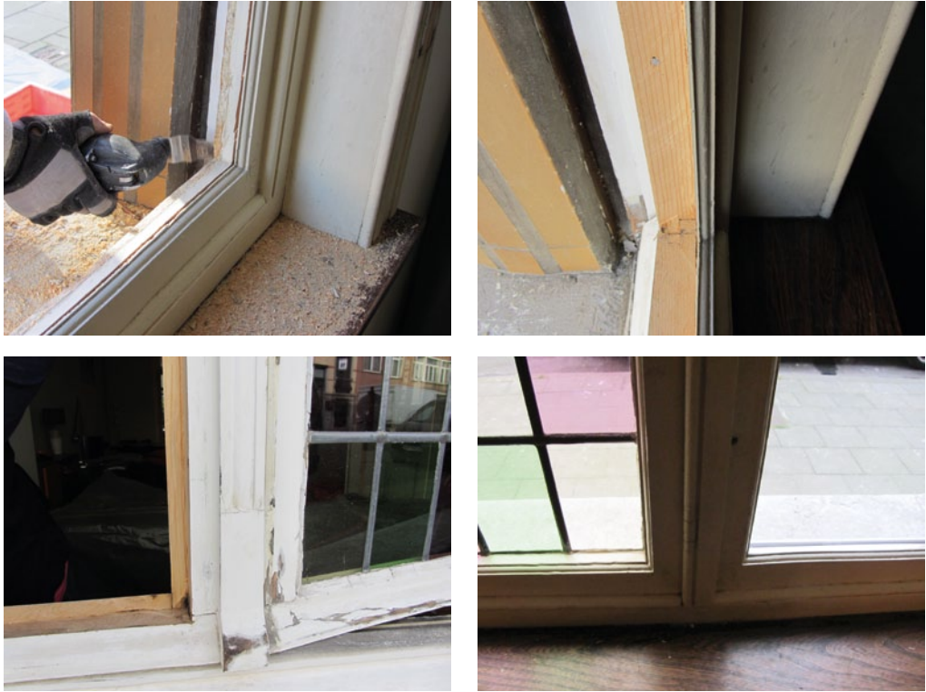
FIG. 84 Uutfreezen van de sponning voor het aanbrengen van dubbel glas in bestaand schrijnwerk (4) (foto's Nathalie Vernimme)
