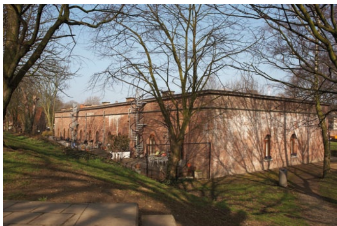
FIG. 44 De Kazemat van op een op afstand gezien, de zonnepanelen zijn nauwelijks zichtbaar (foto Kris Vandevorst)
