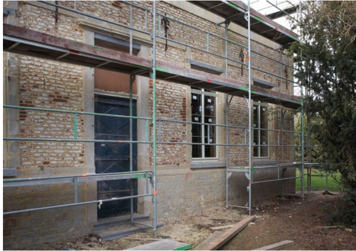
FIG. 85 In deze beschermde pastorie van Meuzegem is een dunne variant van dubbelglas ingebracht in het bestaande schrijnwerk (foto Kris Vandevorst)
