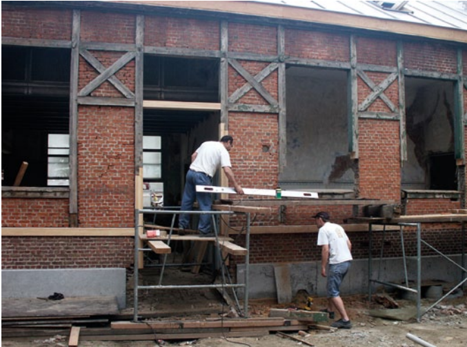
FIG. 20 Plaatselijk herstel van een vakwerkgevel met dezelfde houtsoort, verbandhuisje Zuiderpershuis Antwerpen (foto Willem Hulstaert)
