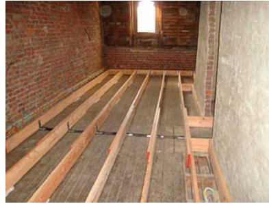
FIG. 58 Isolatie van een zoldervloer. Plaatsen van kepers op de zoldervloer (foto Frederik Mahieu)
