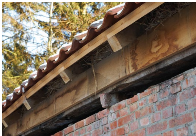
FIG. 53 Nog een detail van het nieuwe dak van de Spikdorenhoeve waarop een lichte verhoging van het dakpakket zichtbaar is (foto Kris Vandevorst)
