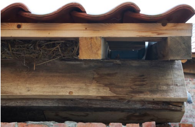
FIG. 52 Detail van het nieuwe dak van de Spikdorenhoeve waarop een lichte verhoging van het dakpakket zichtbaar is (foto Kris Vandevorst)
