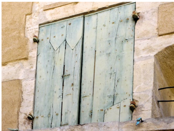
FIG. 21 Plaatselijke herstelling van raamluik (foto Nathalie Vernimme)
