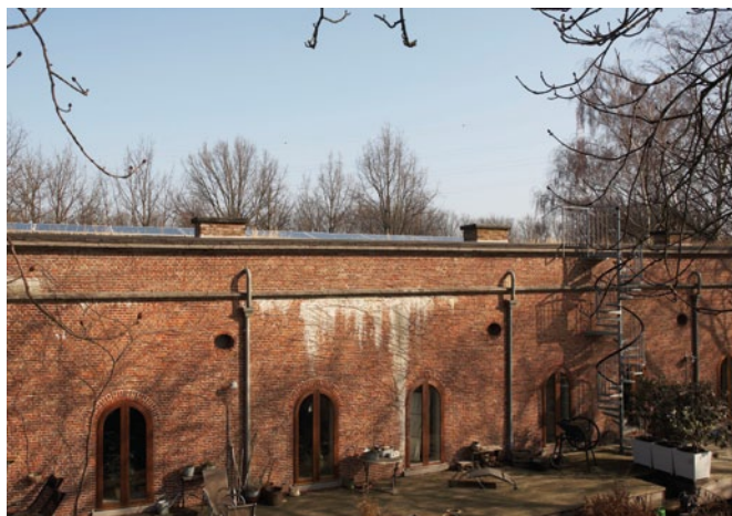
FIG. 42 Een voorbeeld van een esthetisch geslaagde inzet van zonnepanelen op het plat dak van de historische en beschermde gebouwen van de Kazematten Fort Lillo (foto Kris Vandevorst)
