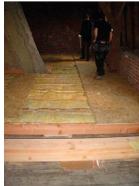
FIG. 60 Isolatie van een zoldervloer. Om de vloer begaanbaar te maken, wordt een dekvloer op de kepers met isolatie ertussen aangebracht (foto Frederik Mahieu)
