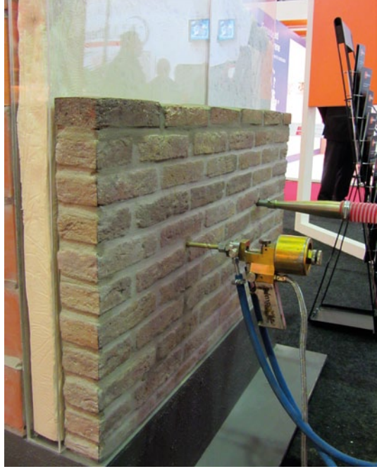
FIG. 62 Illustratie van de techniek voor het inbrengen van spouwmuurisolatie (foto Nathalie Vernimme)
