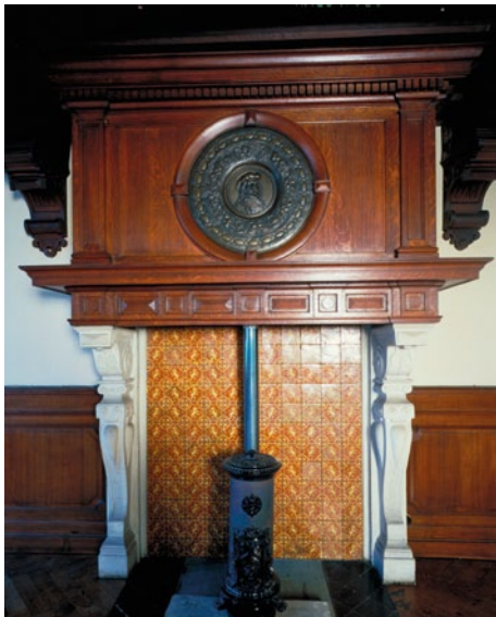
FIG. 23 Decentrale verwarming met een buis-kachel in huis de Groote Mortier in Brugge (copyright beeldbank Onroerend Erfgoed)
