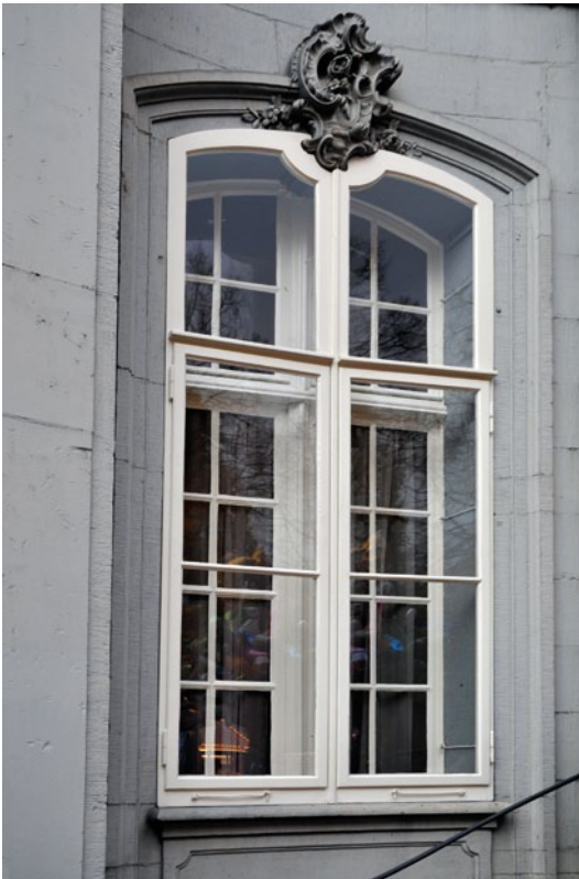
FIG. 79 Voorbeeld van een voorzetraam in een 18 e eeuwse woning in Bazel (foto Madeleine Manderyck)
