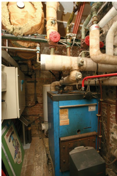
FIG. 32 Een oude stookinstallatie neemt vaak veel plaats in (copyright beeldbank Onroerend Erfgoed)
