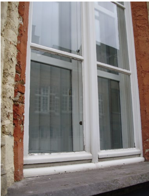
FIG. 74 Achterzetramen met dezelfde indeling als het oorspronkelijk schrijnwerk in een woning in Brugge (copyright beeldbank Onroerend Erfgoed)
