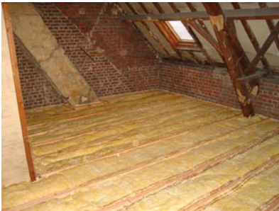
FIG. 59 Isolatie van een zoldervloer. Isolatie wordt aangebracht tussen de kepers (foto Frederik Mahieu)
