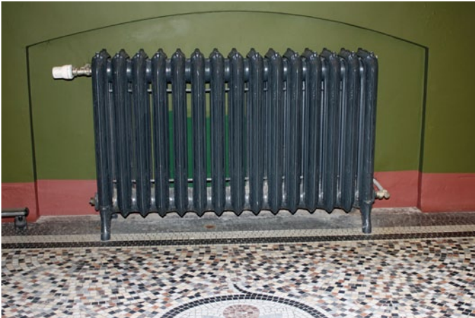
FIG. 34 Gietijzeren radiatoren kunnen perfect aangepast worden aan de hedendaagse noden. Een voorbeeld van de recuperatie van een gietijzeren radiator in de Bijloke in Gent (foto Halewijn Missiaen)
