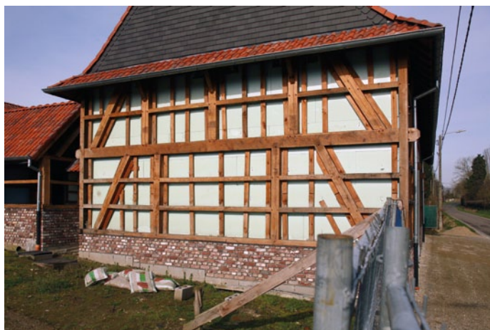
FIG. 64 Gevelisolatie van een woning in vakwerkbouw in Alken (copyright beeldbank Onroerend Erfgoed)
