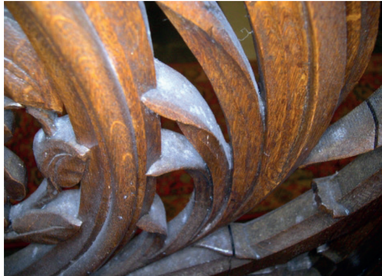
© Anne-Catherine Olbrechts - schimmelvorming door achterblijven van stof.
