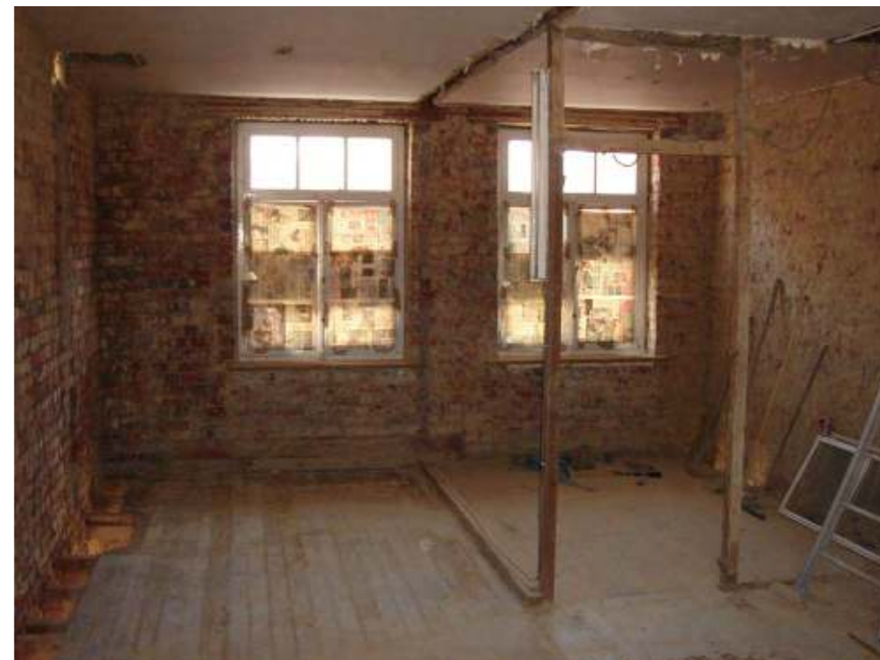
De draagstructuur van deze wederopbouwrijwoning is in goede bouwconstructieve toestand.
