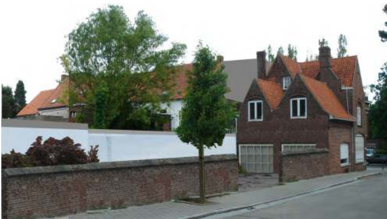
Nieuw volume als uitbouw van de panden in de Reningeststraat. Het lage volume raakt aan de bouwlijn van de Kasteeldreef.
