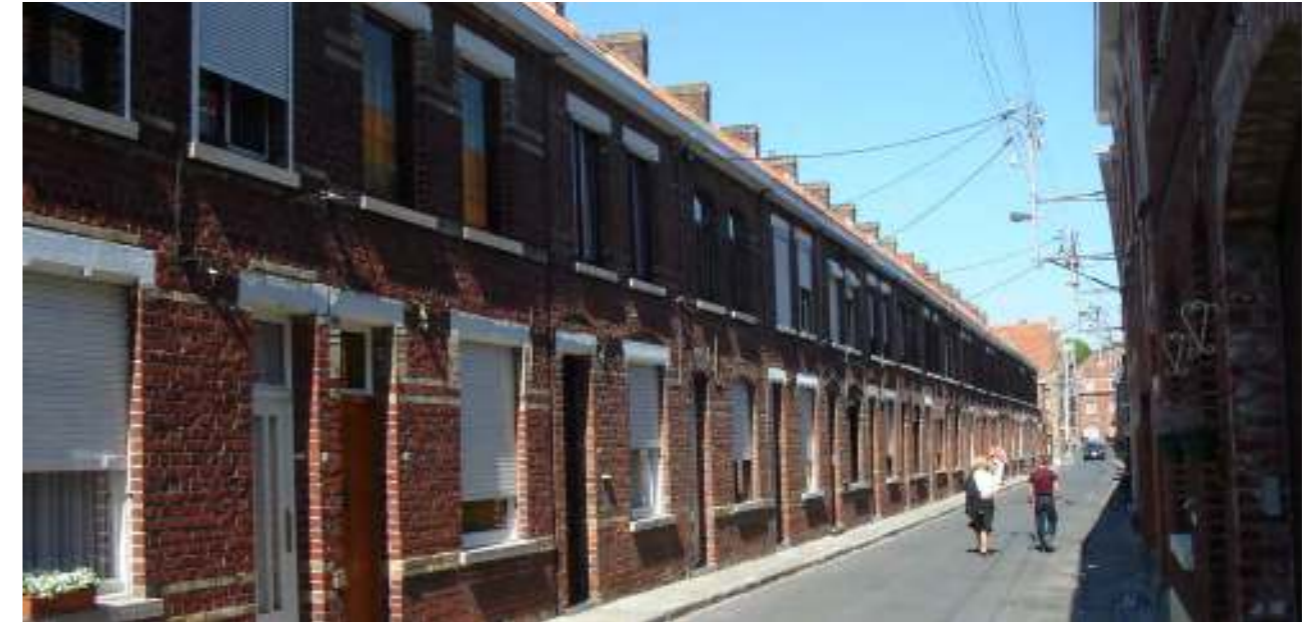
uniformiteit in gevel en hoofdvolume
