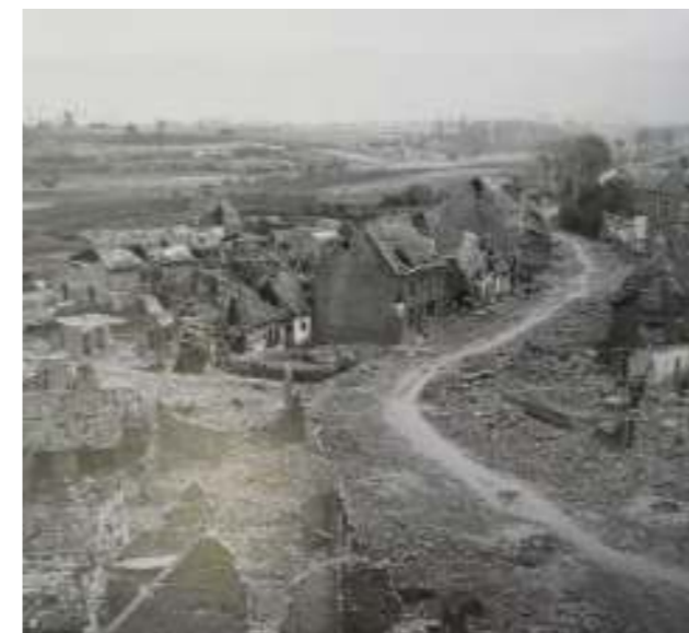
Westouter, 1918: quasi totale vernieling
