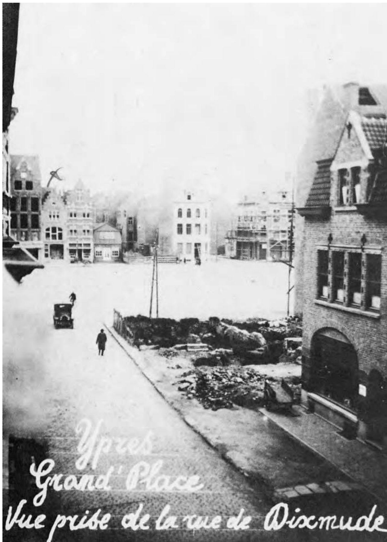
Op deze foto is de verbreding van de Diksmuidestraat zichtbaar in de niet-gepaveide zone tussen de oorspronkelijke straat en het nieuw aangelegde voetpad.
