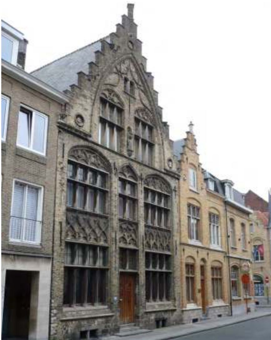
Historische waarde: de gevel van Huis Biebuyck in de Diksmuidsestraat (Ieper) werd in detail opgetekend en na de oorlog volgens het oud ontwerp hersteld en vervolledigd.
