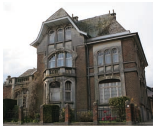
↑ Wederopbouwarchitectuur, Beselare © Eric Malfait
