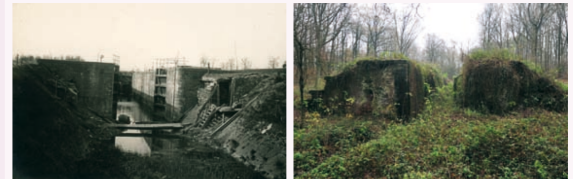
↑ Op het volledige kanaaltraject werden 16 sluizen gebouwd. Alle sluizen waren van hetzelfde type.
