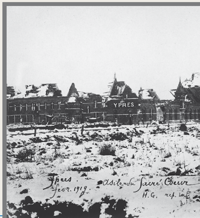
Ieper, de Heilig Hartkliniek was één van de weinige gebouwen in Ieper waarvan de ruïnes in 1919 nog herkenbaar waren.
