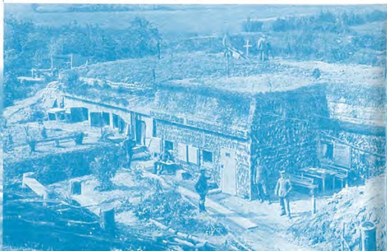
| Duitse betonbunker bij de Palingbeek (1916)
