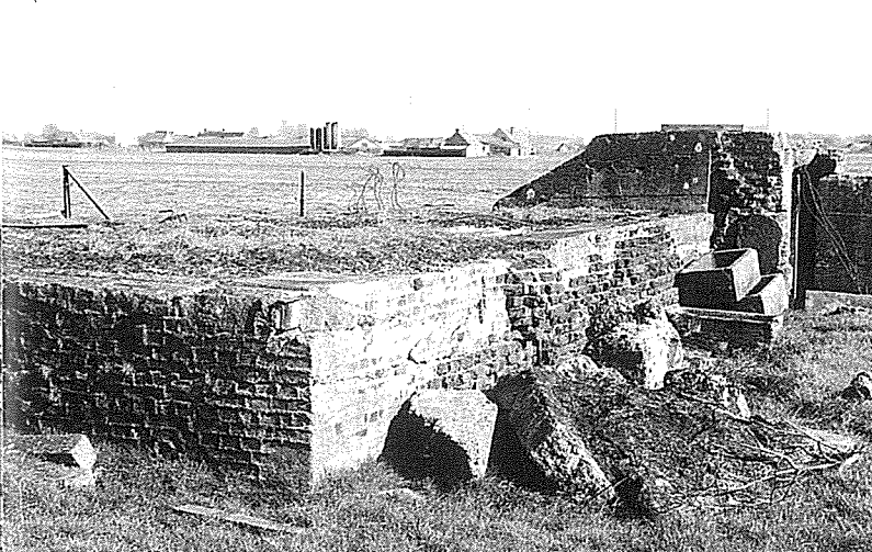
| Langemark, Duitse bunker gegoten binnen de hoeve Vee Bend
