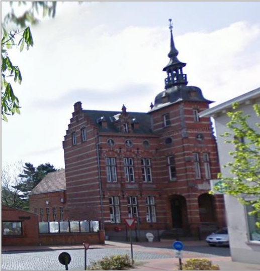
Figuur 7 : Hoge belevingswaarde dakvlakken hoofdgebouw, lage belevingswaarde dakvlak recentere achterbouw (© 2017 Google)
