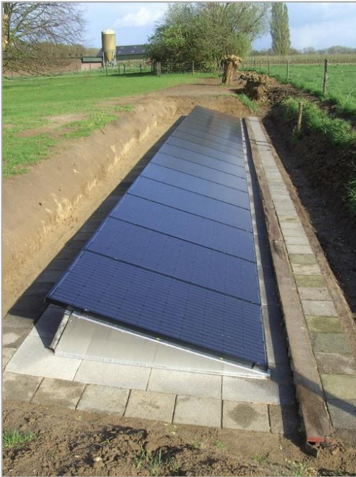
Figuur 10 : Verzonken opstelling: de zonnepanelen zijn volledig onder het maaiveldniveau geplaatst. (© Ecodome Zonnepanelen B.V.)
