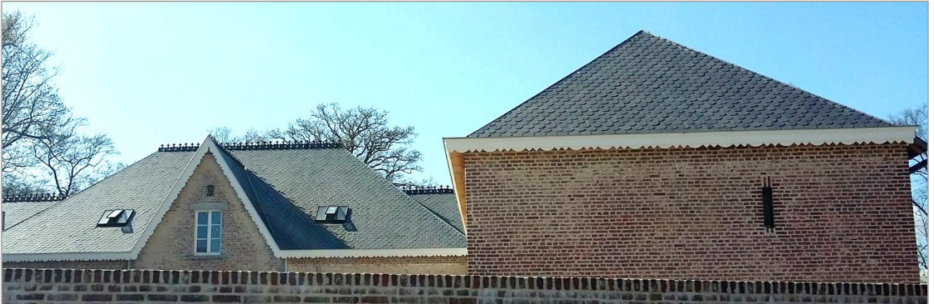
Figuur 4 : Natuurleien bedaking met decoratieve afwerking van de dakranden en nok (© Onroerend Erfgoed)
