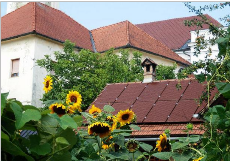
Figuur 9 : Door de kleur van de zonnepanelen aan te passen aan het omringende dak kan men streven naar een verminderde zichtbaarheid van de installatie. (© Bisol Group)
