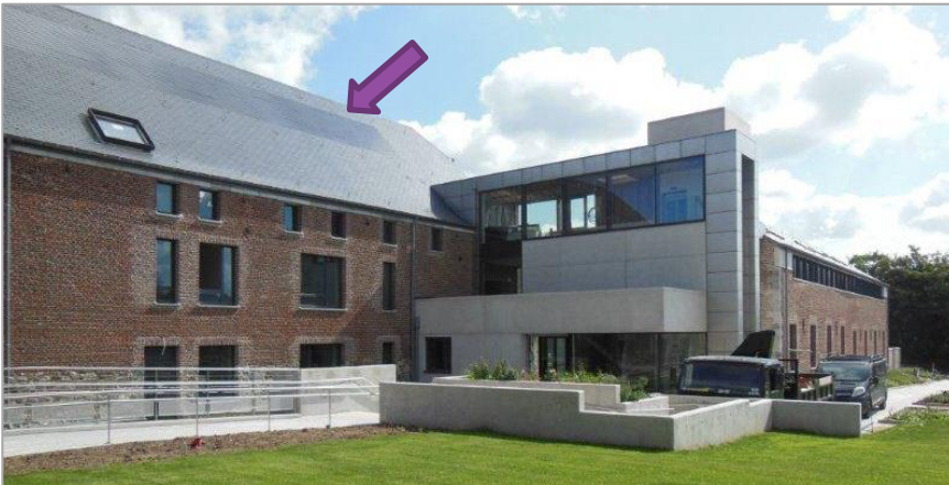
Figuur 2 : Stroomproducerende leien op een deel van het gemeentelijk administratief centrum van Wanze (© Eternit)
