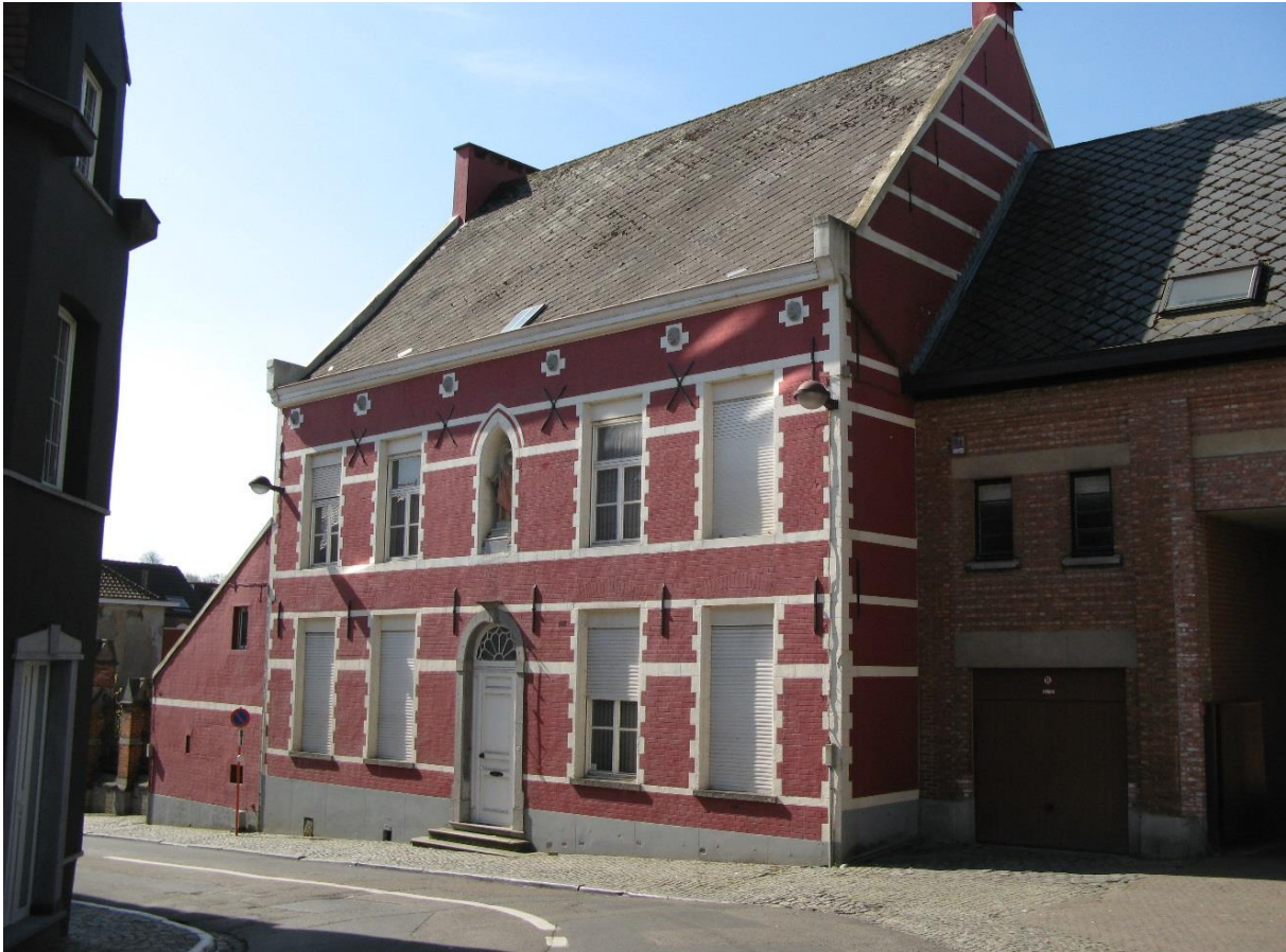
Voorgevel van de pastorie voor restauratie
