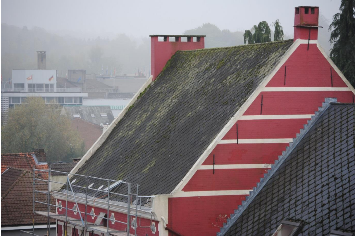
Gezicht op het dakvlak en de opgaande muren
