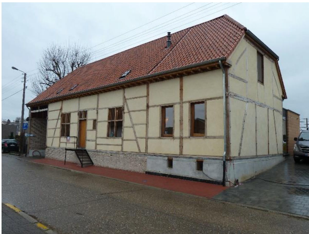
Gezicht op de straatgevel van de vakwerkhoeve in Alken, na restauratie. In het dak zien we de overgang tussen het 17de- en het 19de-eeuwse deel van het gebouw.
