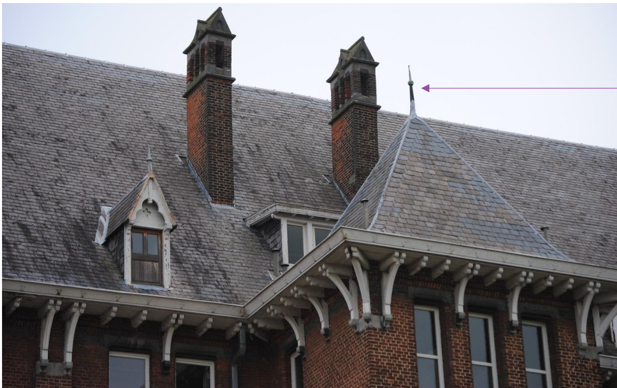
Het Heilig Hartinstituut Heverlee is beschermd omwille van de historische en architectuurhistorische waarde. De leien zadeldaken worden verlevendigd met dakkapellen met smalle houten fronten, uitgesneden houtwerk en pirons, gedecoreerde schouwen in baksteen en blauwe hardsteen, houten kroonlijsten.
