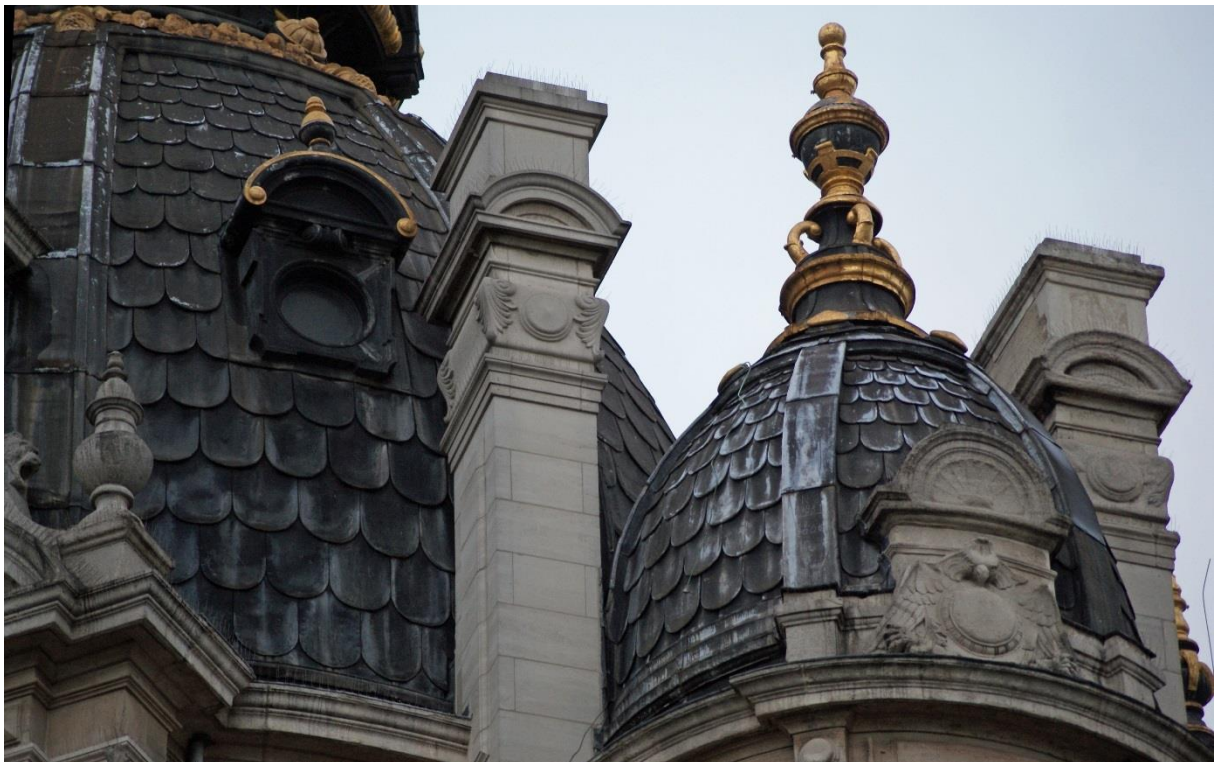
Het neobarokke voormalige hotel Métropole in Antwerpen, beschermd als monument, heeft naast een heleboel bijzondere details een zeer specifieke loden dakbedekking.
