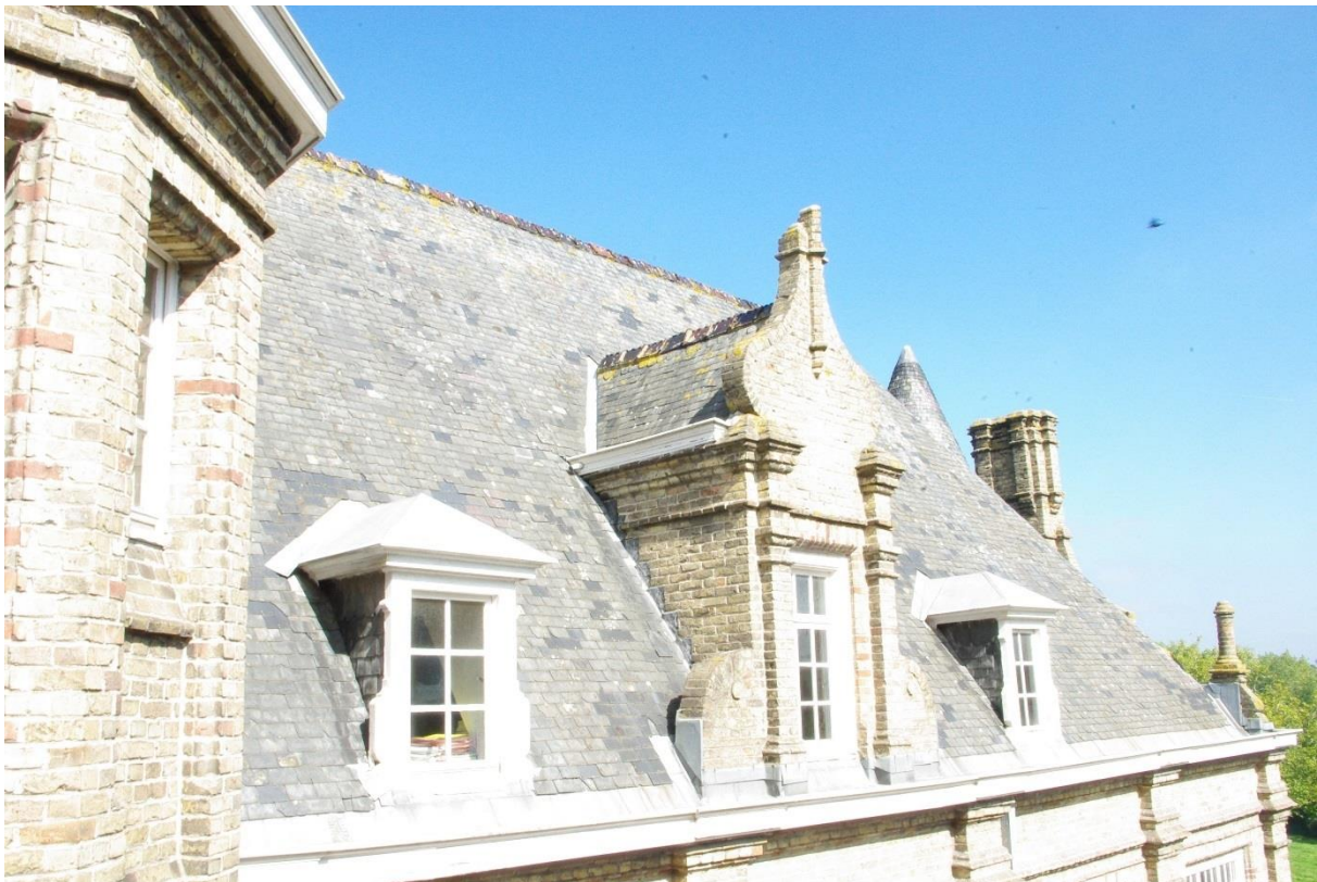
Houten dakvensters en stenen klimmende dakvensters in het Kasteel De Warande in Kemmel. Om het exterieurbeeld niet aan te tasten werden de dakkapellen aan de binnenzijde minimaal geïsoleerd. (foto architect D. Vanhove)
