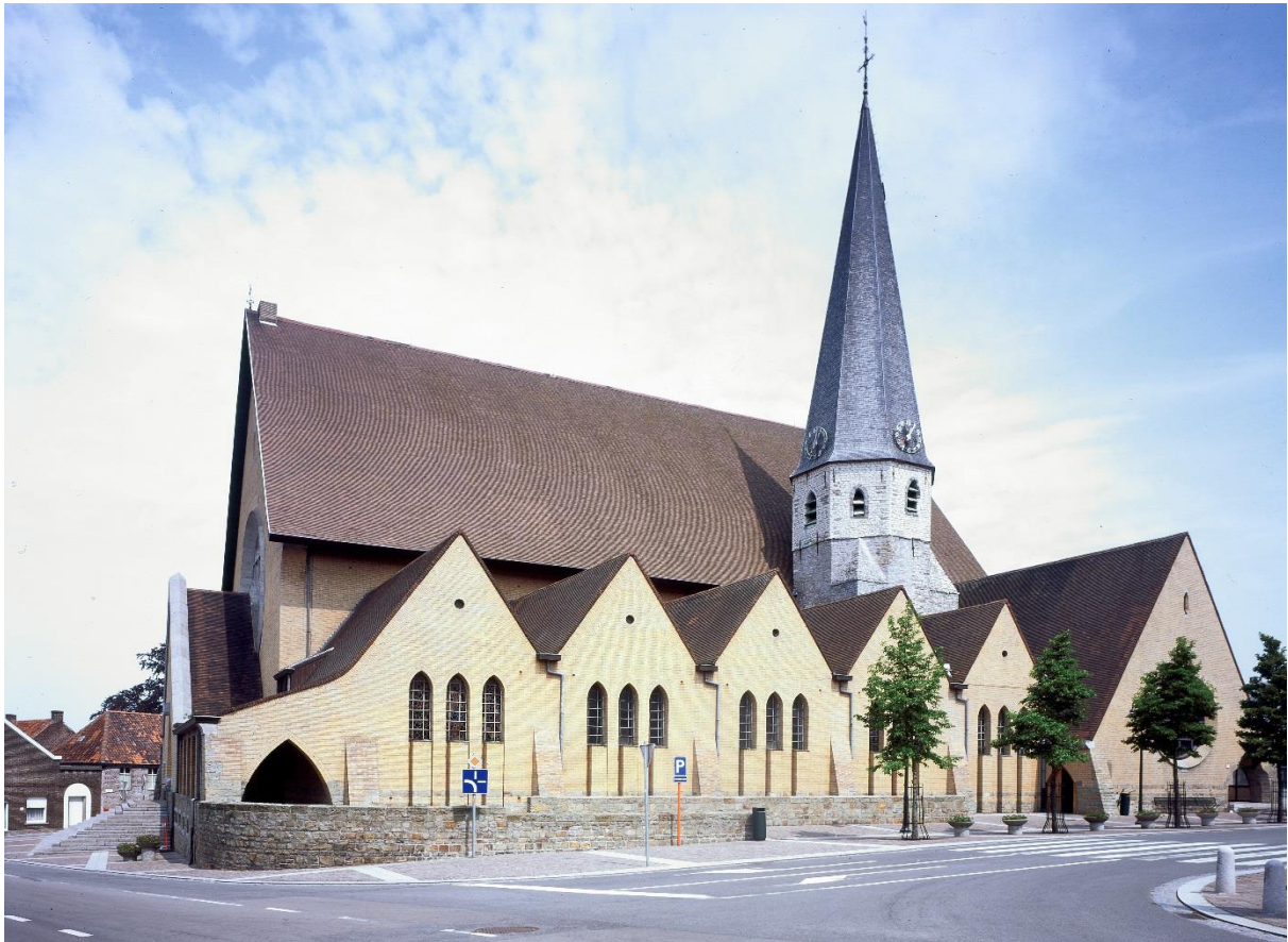
De Sint-Amanduskerk in Zwevegem heeft een achthoekige gotische toren met ingesnoerde naaldspits(foto O. Pauwels).
