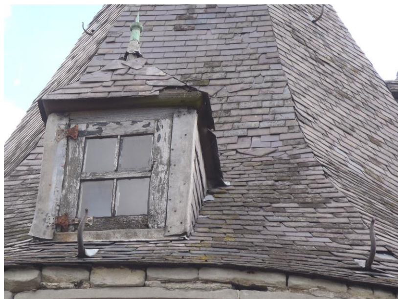
Oude dakkapel op torenspits met leien dakbedekking (© Monumentenwacht Antwerpen).
